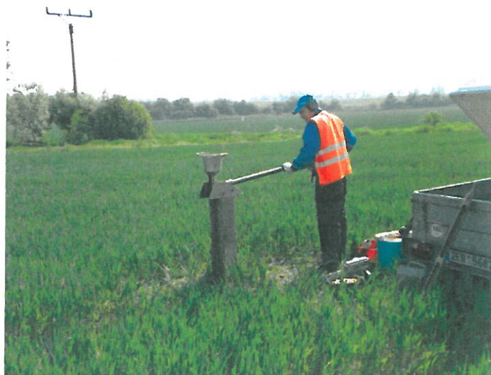
Foto č. 4: Vrtání průzkumné geologické sondy GS-1.
